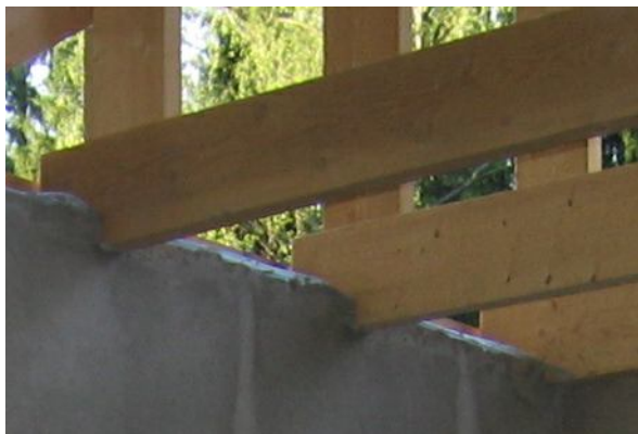
Балки для крепления потолка, 200*50 мм.
